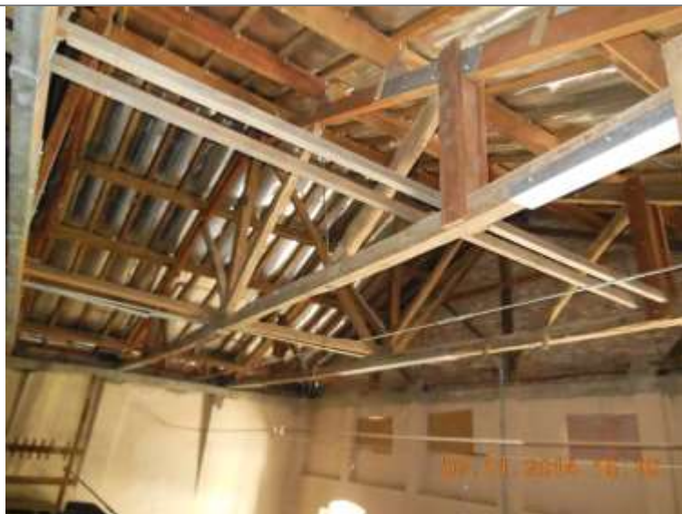
Estrutura do telhado recuperada e reforçada com chapas metálicas.
