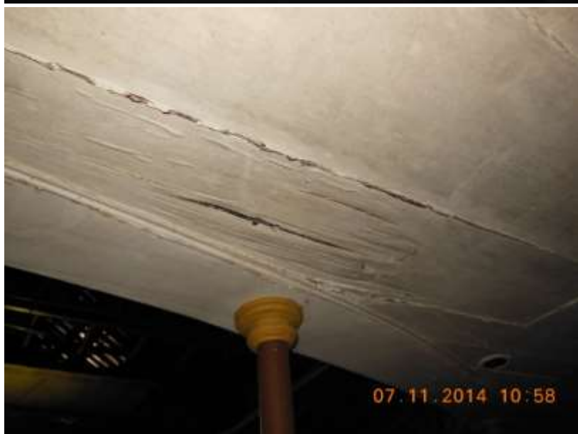
Madeira danificada por fungos, lugar de empoçamento de água dentro do desvão do entrepiso.
